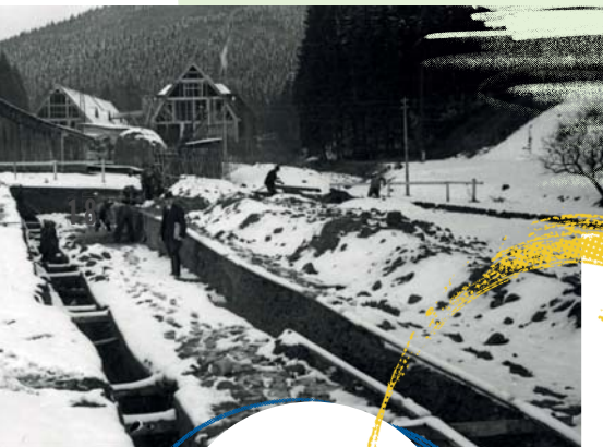
Zbrojovka Vsetín v době výstavby
